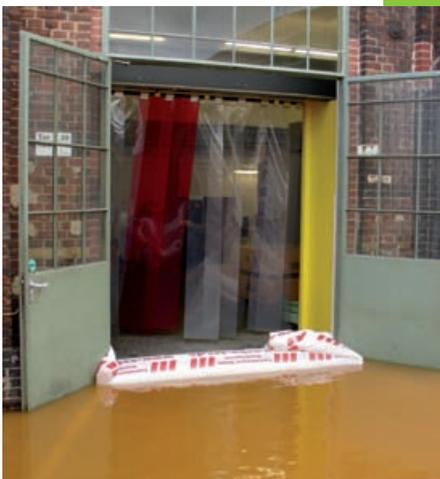
Le barrage de porte permet de retenir les liquides contaminés ou de lutter contre les inondations.
