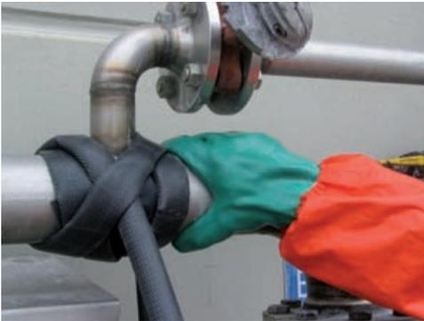
L'étanchéité des fuites qui se produisent sur des tuyauteries sous pression, éléments moulés et robinetteries ne sont généralement pas ou que difficilement maîtrisables avec des coussins d'étanchéité de fuites standards.
