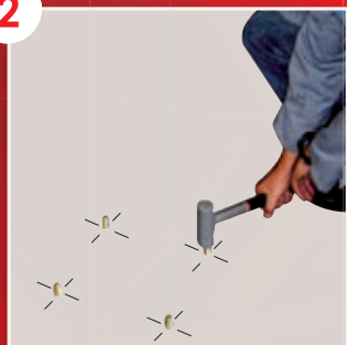
Mise en place des goujons
