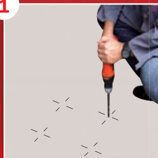
Perçage des trous de fixation
